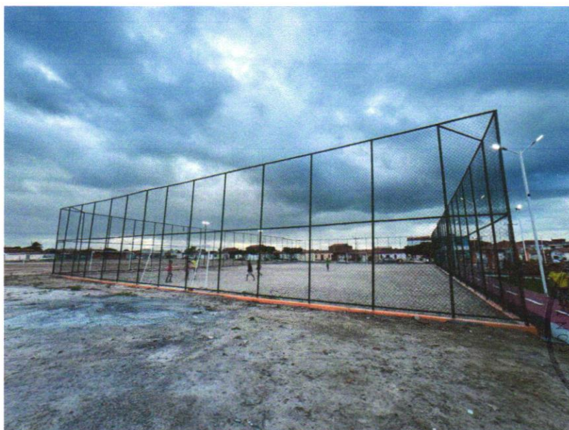
Foto 04 - ALAMBRADO PARA QUADRA POLIESPORTIVA, ESTRUTURADO POR TUBOS DE AÇO GALVANIZADO, (MONTANTES COM DIÂMETRO 2", TRAVESSAS E ESCORAS COM DIÂMETRO 1 ¼ ), COM TELA DE ARAME GALVANIZADO, FIO 10 BWG E MALHA QUADRADA 5X5CM (EXCETO MURETA). AF_03/2021
